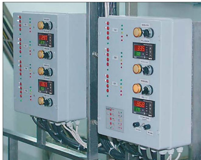
*Фото 3. Шит управления на базе измерителя двухканального с универсальными входами ОВЕН ТРМ200 и измерителя-регулятора двухканального с универсальными входами ОВЕН ТРМ202, установленный на ЗАО «Кореновский молочно-консервный комбинат»*
