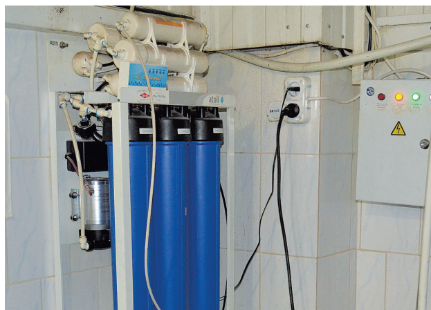
Фото 2. Установка обратного осмоса
